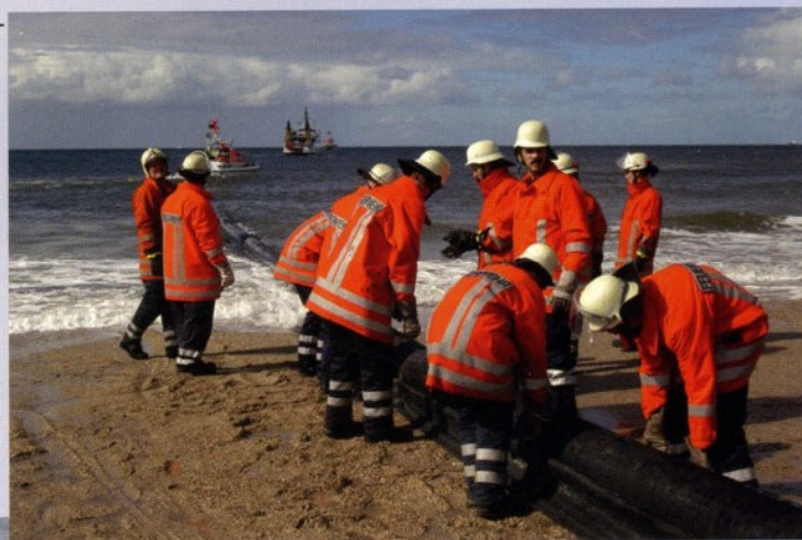
Mit manpower wird der pressluftgefüllte Hochseesöschlägel zu Wasser gelassen.
